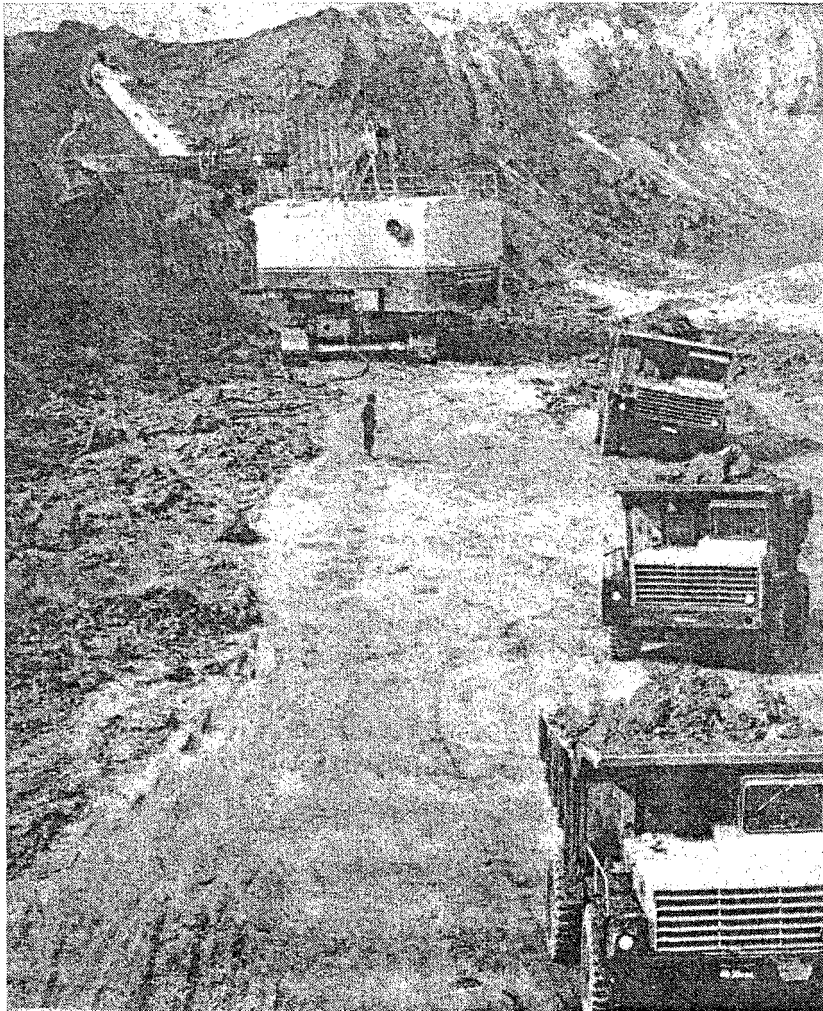
Світлина 28. Добування руди відкритим способом у Домбровському кар'єрі. Світлина Б. О. Мінделя з альбому Івано-Франківщина. - К. - «Мистецтво», 1978.
