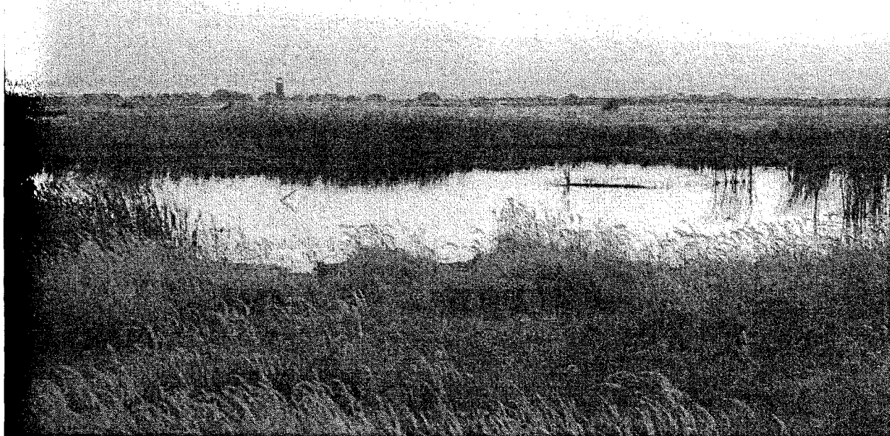
Рисунок 1. Просадочне озеро на поверхні хвостосховища.
