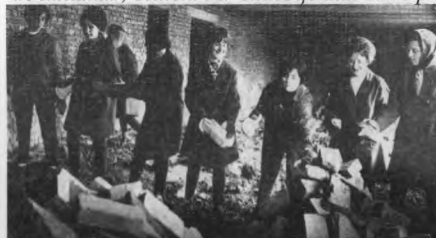
Студенти працюють на будівництві 5-го гуртожитку. 1976 р.
