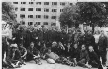
Студентська бригада на будівництві 5-го гуртожитку 1976 р.
