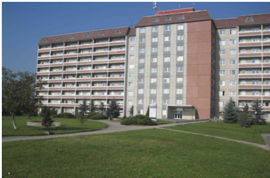
Корпус Обласної клінічної лікарні, в якому розміщене оториноларингологічне відділення
