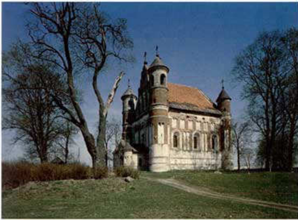
Помнік беларускага абарончага дойлідства. Царква-фартэца ў в. Мураванка Шчучынскага раёна. Пачатак XVI ст.
