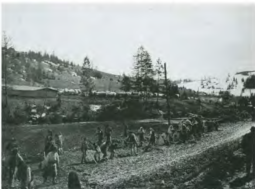
Ремонт дороги в с. Опорець
