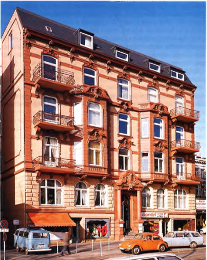
Відремонтований жилий будинок часів грюндерства в Гамбурзі
