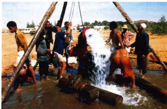
Ремонт артезіанського колодязя в Єгипті
