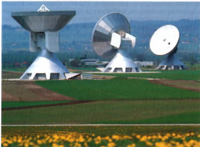
Наземна радіостанція в Райстінгу, Баварія
