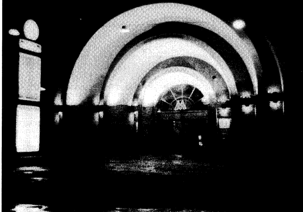
Освещение наземного вестибюля станции метро «Красные ворота». Архит. Н.И. Щелетков, 1997, фото автора
