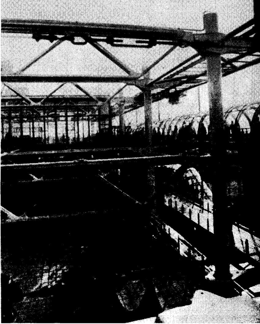
Центр Искусств им. Жоржа Помпиду — один из первых и наиболее знаменитых примеров общественного здания, решенного в стилистике “хай-тека”. Архит. Р. Пиано и Р. Роджерс, 1977
