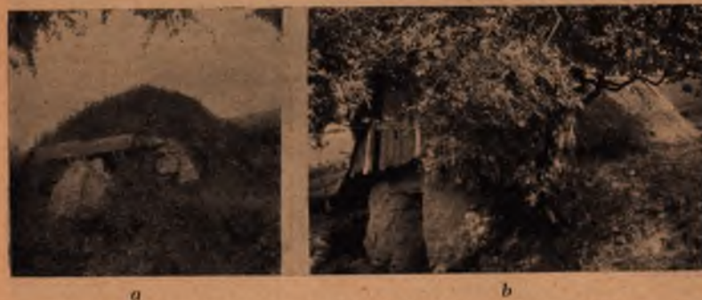
Ryc. 21. Piwnice: a b Serednie Wielkie.
