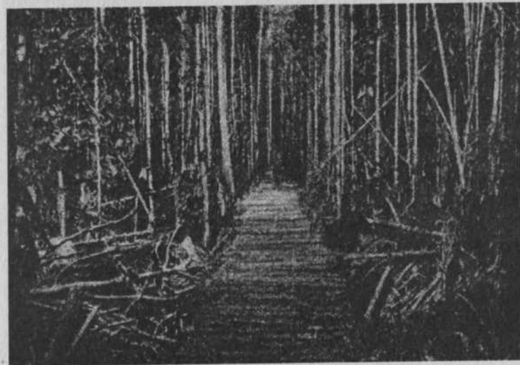
Прокладка дороги въ болотистомъ лѣсу на остр. Борнео.
