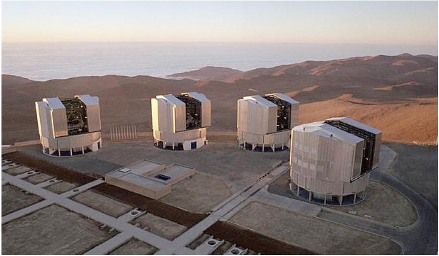
Рис. 3. Інтерферометр із 4-х Дуже Великих (4x8,2м) Телескопів Європейської Південної обсерваторії – (ESO Very Large Telescope Interferometer), за роздільною здатністю цей інтерферометр еквівалентний дзеркалу діаметром 130 м.
