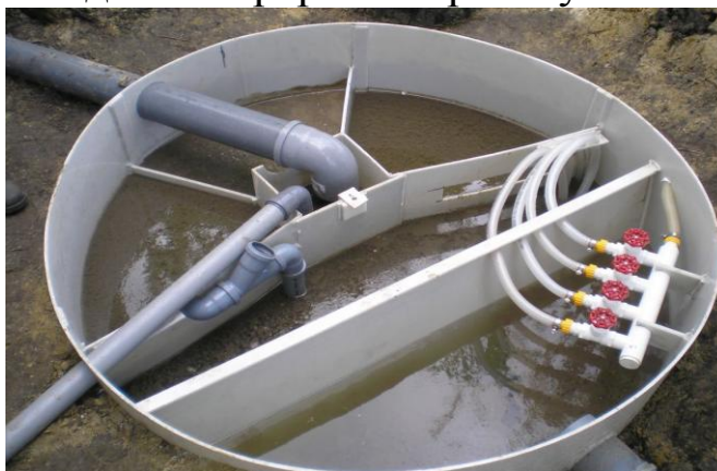
Рис. 1.16. Аеротенк з технологією видалення біогенних речовин
