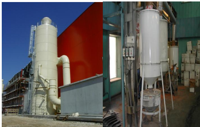
Рис. 1.18. Циклон – пристрій для збору твердих забруднюючих частин
