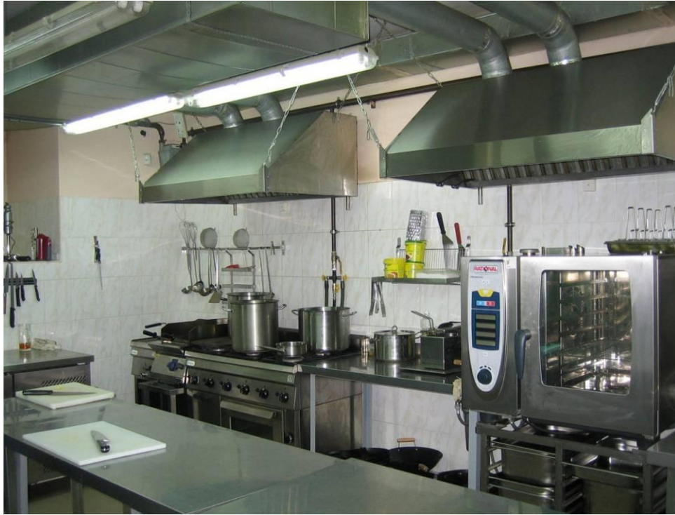
Рисунок 2.1 – Зовнішній вигляд системи вентиляції кухні (гарячого цеху)
