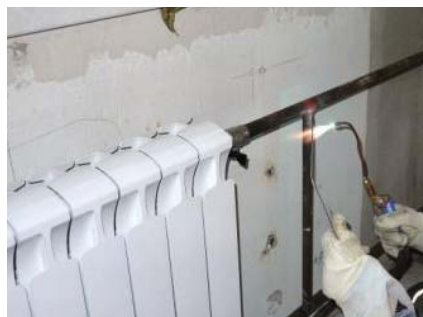
Мал. 10 Газозварювальні роботи за допомогою етину
